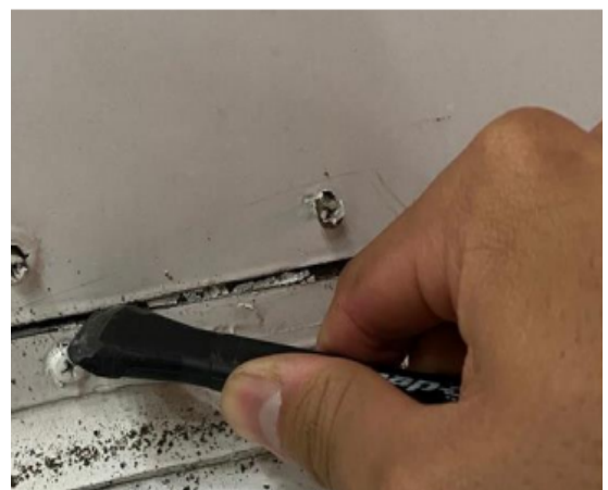
Gambar 3. Membersihkan sealant menggunakan scrapper
