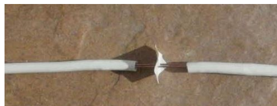
Gambar 7. Penyambungan kabel
